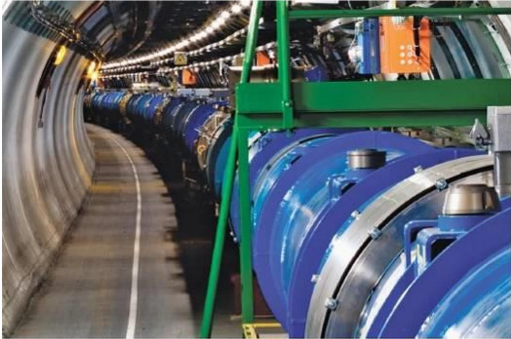
Interior del túnel del LHC, con los imanes dipolares instalados y listos para entrar en funcionamiento. © CERN
