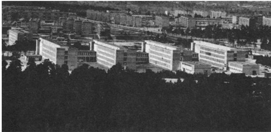
Foto 19. Nuevos edificios de viviendas en la década de 1960.
