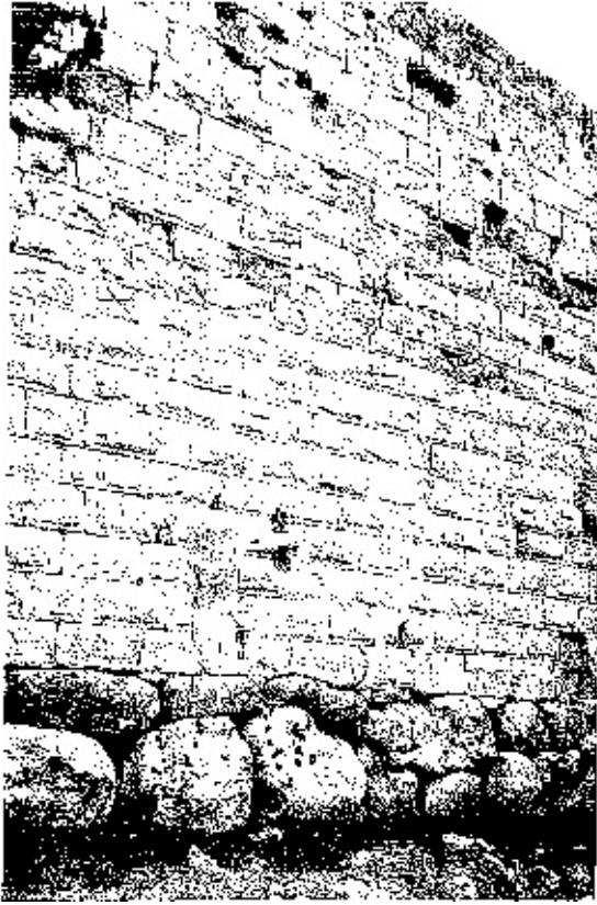
Figura 6.5. La muralla romana de Tarraco con filas de piedras prerromanas en la base.
