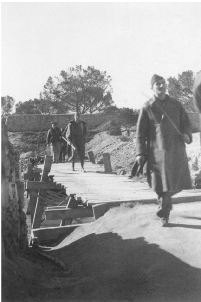
Este era el único puente, provisional, sobre el Manzanares entre la Ciudad Universitaria y el resto de Madrid. Invierno de 1938. (Archivo Nacional de Estados Unidos, RG 165, caja 1739.)
